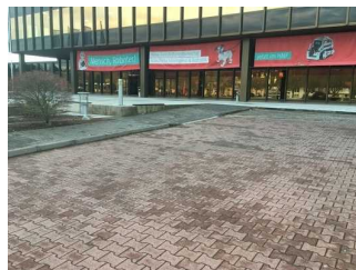
Weg außen (Parkplatz - Eingang)
